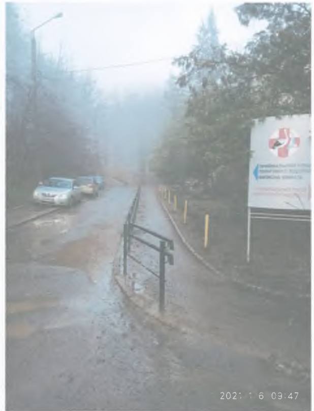
Огорожа, відмежовує проїжджу частину від шляху пересування МГН
